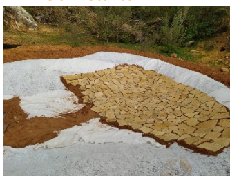
5. Arena y piedra
