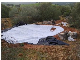
4. Plástico y segundo geotextil
